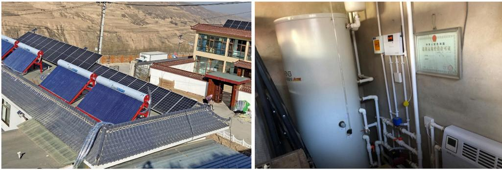
图 3-7：太阳能光伏 + 光热 + 电锅炉案例图片
