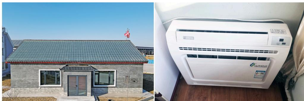
图 3-6：太阳能光伏+空气源热泵热风机案例图片
