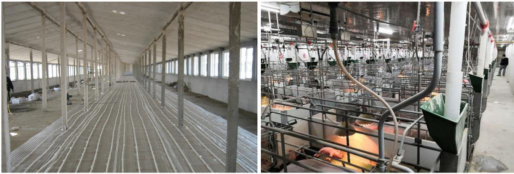
图 4-4：规模化生猪养殖集团采用电取暖和空气源热泵供暖
