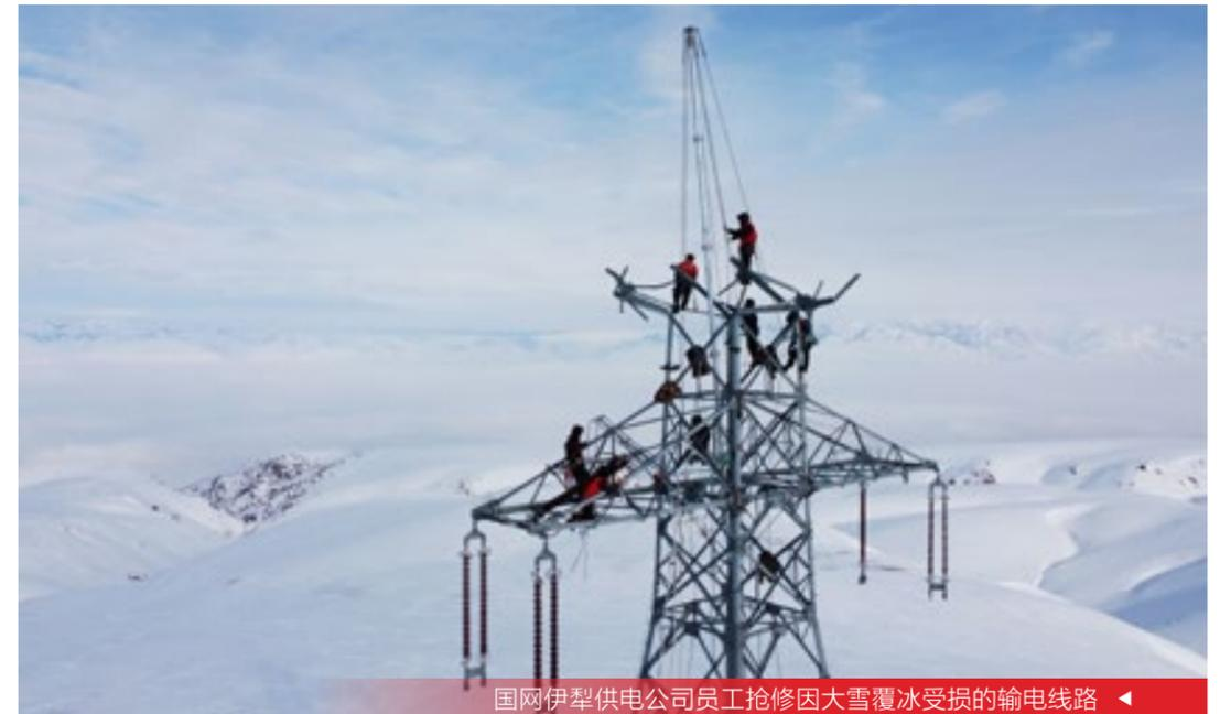
◀ 国网伊犁供电公司员工抢修因大雪覆冰受损的输电线路
