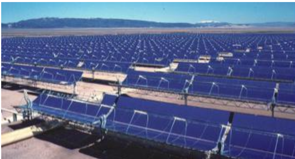
图：建于上个世纪 80 年代的 SEGS 槽式电站实景图
