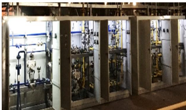
图 14 新一代智能底吹集成供气系统及控制模型
