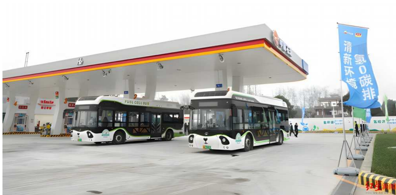
郫都区中石油古城油氢合建站
