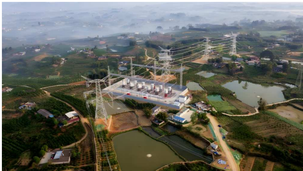
尖山-彭祖500千伏线路加装串抗工程
