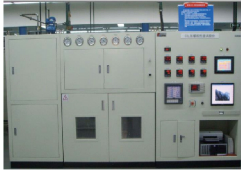
图4-10 CO 2 压缩机性能试验台
