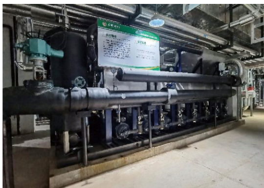
图5-9 安徽正刚新能源科技有限公司兆瓦级跨临界二氧化碳冷热联供装置
